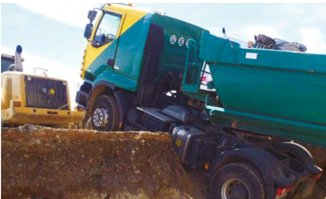
Crevasse précédant un cercle de glissement en tête de talus de verse
