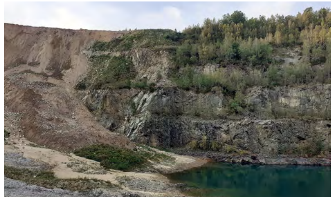
Présence d'eau en pied de talus
