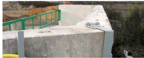
Butée en béton armé pour la verse de matériaux d'apport
