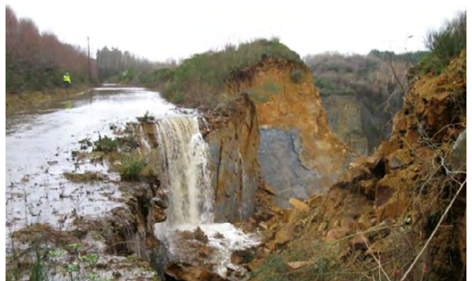
Effondrement partiel sous l'effet du débordement d'un cours d'eau
