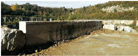
Butée en béton armé pour la verse de matériaux d'apport
