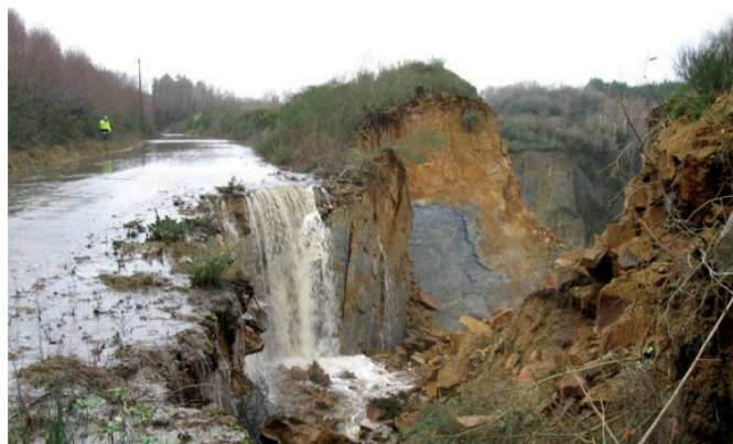
Effondrement partiel d'un front de taille sous l'effet du débordement d'un cours d'eau
